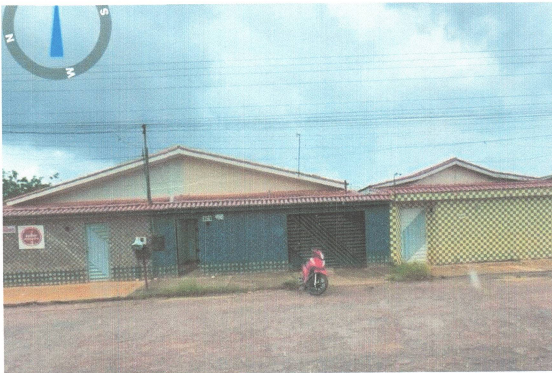
Figura 1: Fachada frontal externa do imóvel.
