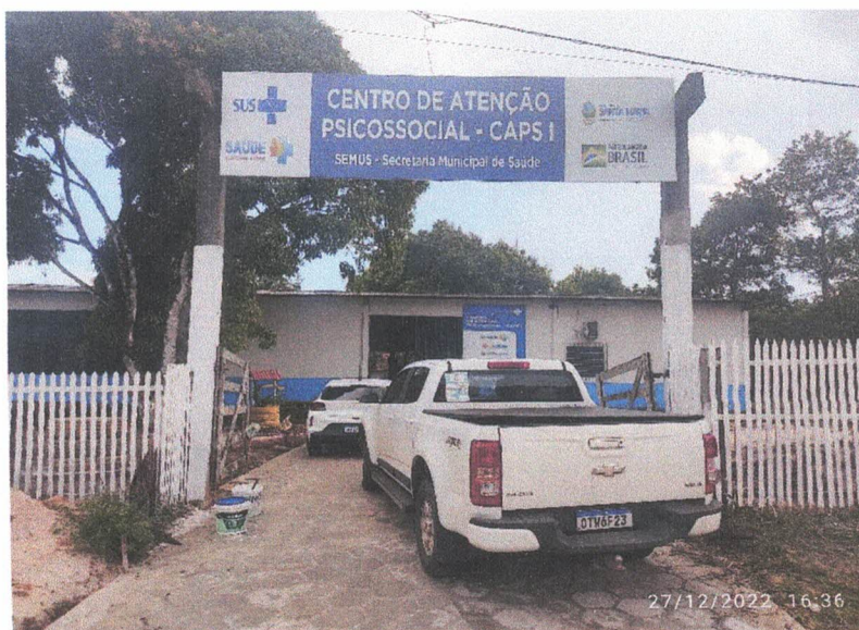
Figura 2: Foto da fachada.
