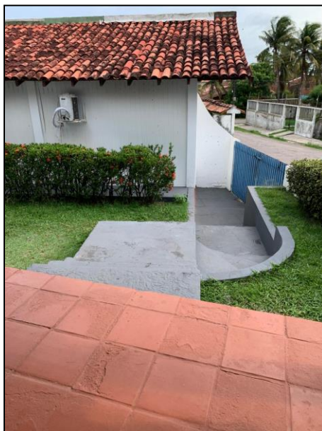
IMAGEM 30 – Vista externa Acesso ao Bloco Anexo
