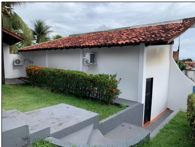
IMAGEM 31 – Vista externa Bloco anexo
