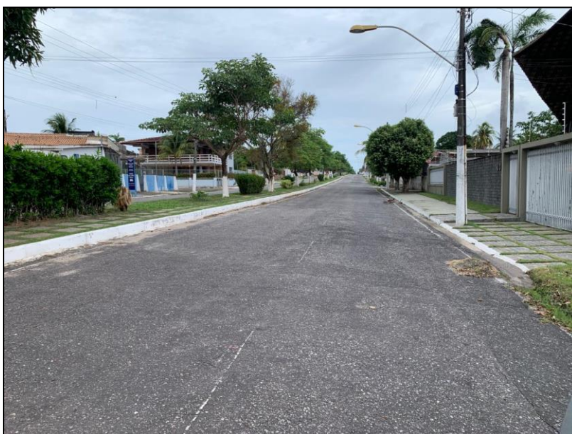
IMAGEM 03 – Acesso pela Avenida Júlio Cesar, sentido Rua Tiradentes
