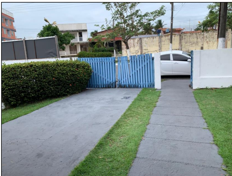
IMAGEM 10 – Vista externa acesso a edificação (pedestre e veículos)
