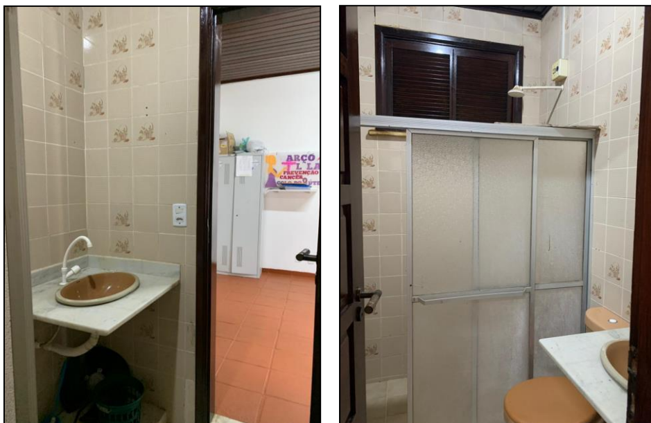
IMAGEM 23 – Vista interna Banheiro Sala 03 (Feminino e Masculino)
