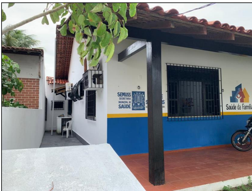
IMAGEM 08 – Vista Externa Fachada Lateral Esquerda
