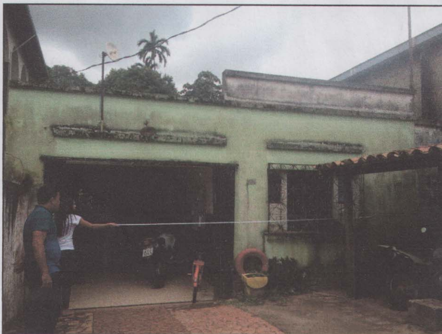
Vista frontal interna da fachada da edificação
