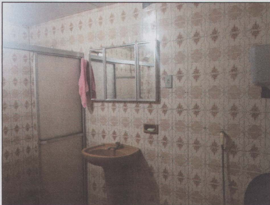
Vista interna banheiro da edificação
