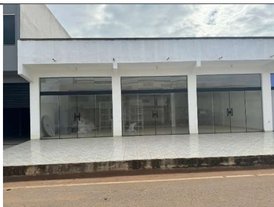
Foto 02: Fachada da edificação estudada
