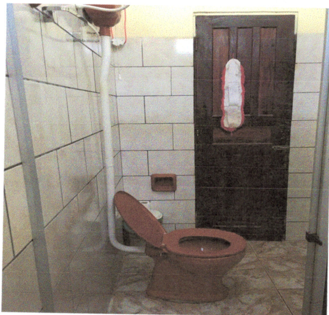
Foto 1.17 a 1.20 – Visão do Banheiro
