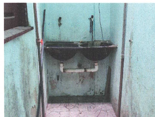
Imagem 06: Pias da Área de Serviço da Residência (Térreo).
