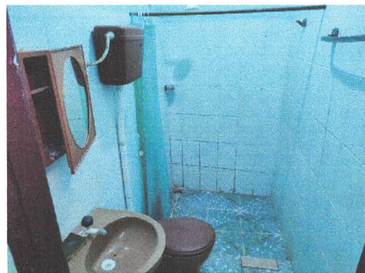
Imagem 05: Banheiro da Residência (Térreo).
