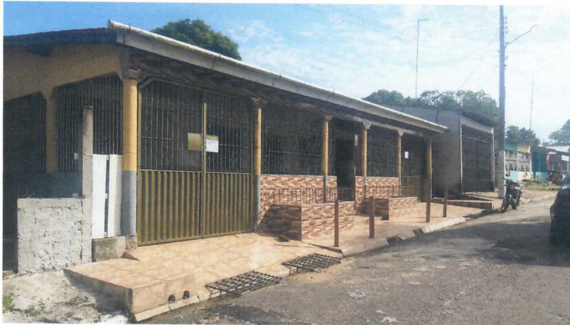
FOTO: 01-VISTA DA FRENTE
