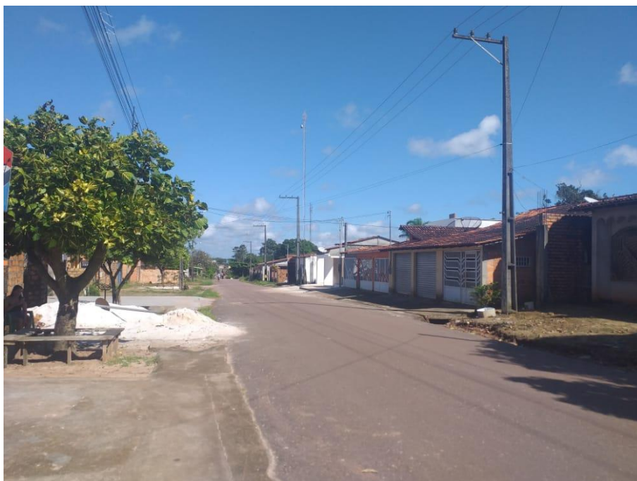
Vista longitudinal Rua Germano Melo, sentido Avenida João Pessoa (PA-424)
