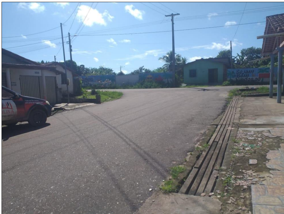
Vista longitudinal Rua Germano Melo, sentido Rua Cezarino Doce
