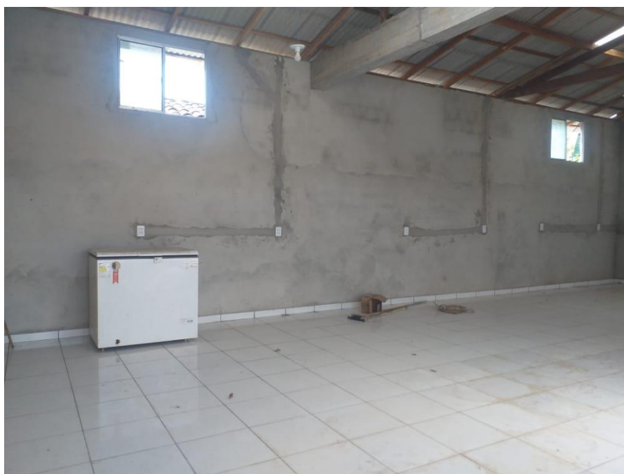
Vista interna Depósito
