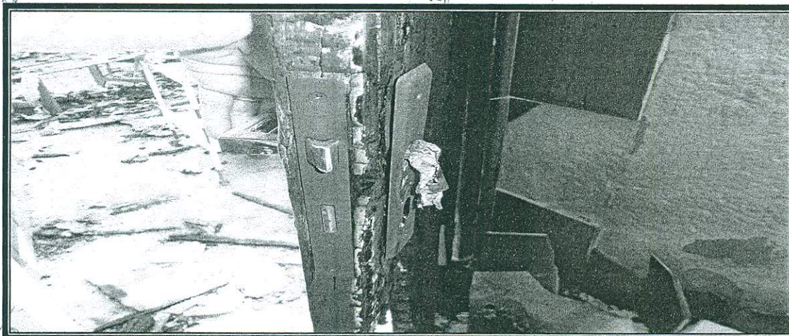
Foto 17 - Derretimento da maçaneta de alumínio pelo lado de dentro da sala de Vacina.
