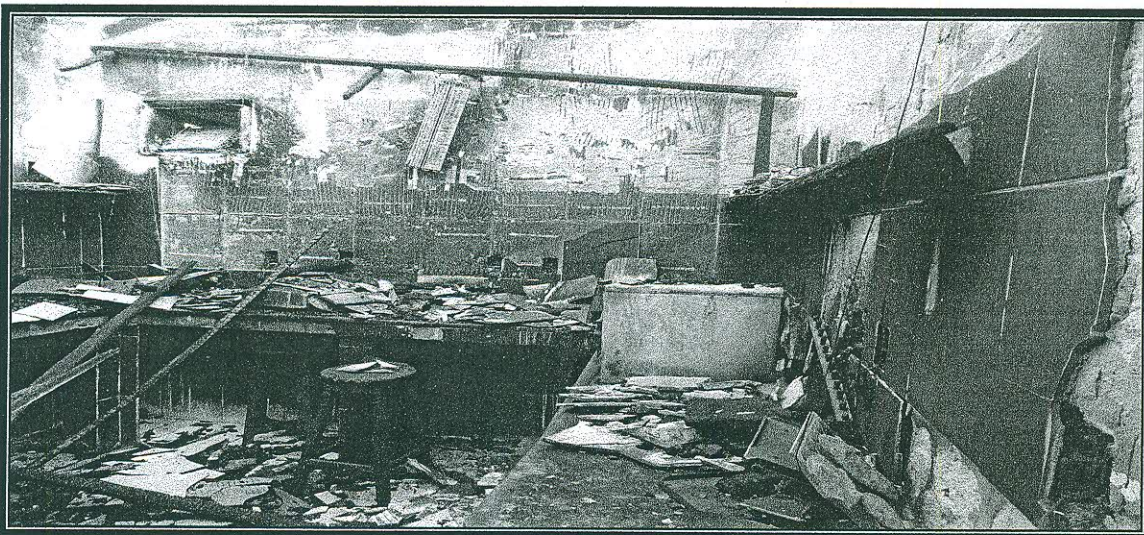
Foto 26 – Sala Laboratório I: Propagação descendente na vertical, conforme mostram as marcas nas paredes.
