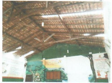
Imagem 10-Cobertura em estrutura de madeira
