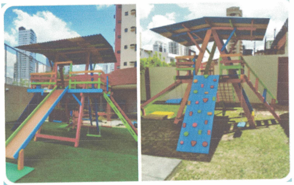
Figura 4- Assoalho medindo 3 m de largura x 2,20 m de comprimento, cobertura com telha brasilit
