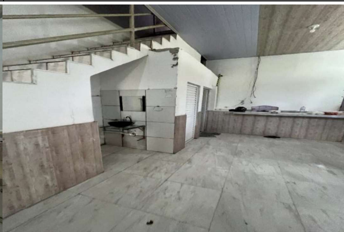
escada acesso pav sup
