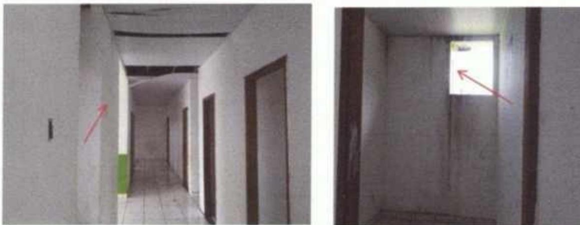
**Foto 8 e 9: Deterioração de forro e Manchas nas paredes**
