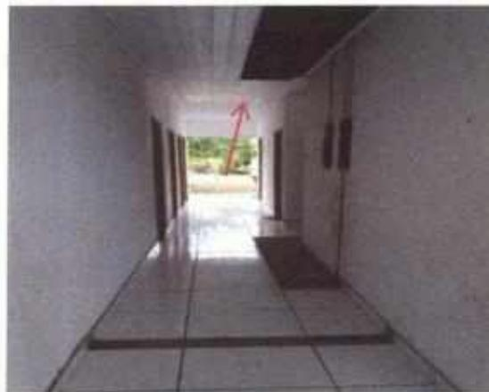
**Foto 6 e 7:** Falha executiva Telha e Deterioração de forro
