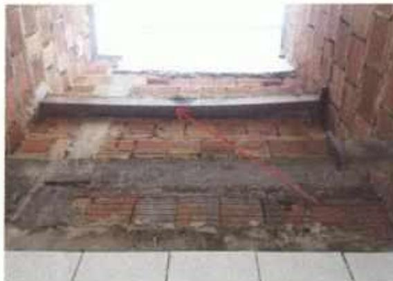
**Foto 4 e 5:** Calha e detalhe de banheiro sem cobertura
