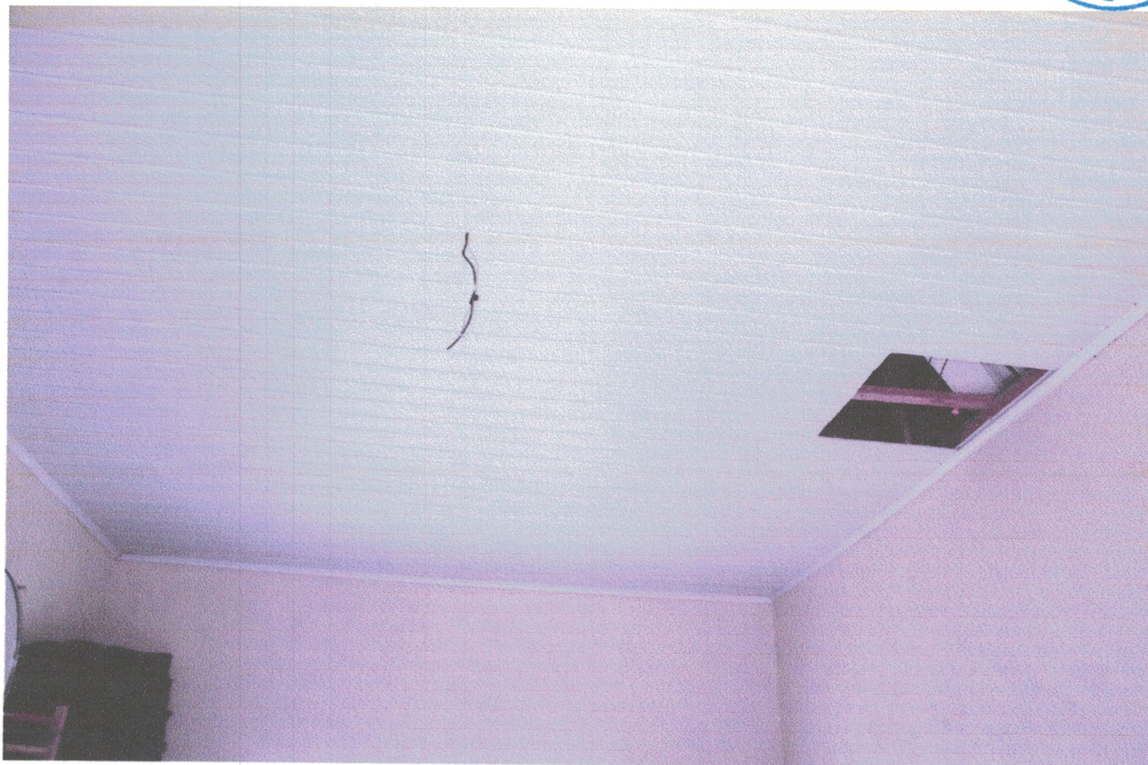
Figura 05: Forro danificado
