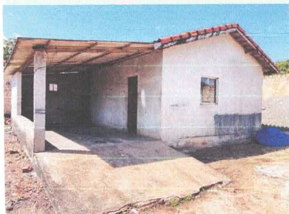
Imagem 05: Lateral da casa
