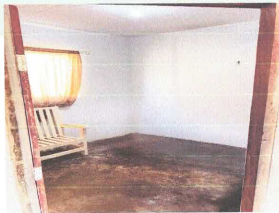
Imagem 06: Cômulo do imóvel
