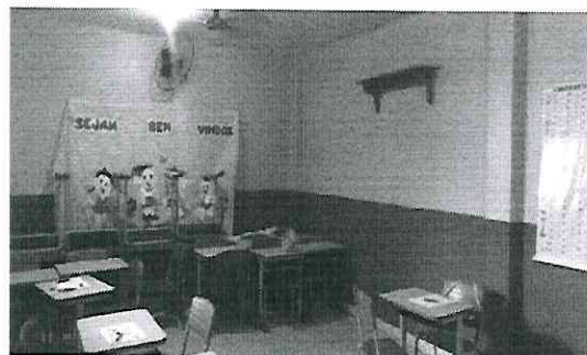
Figura 4: Sala de aula 1 com pintura padrão, forrada e com rodapés
