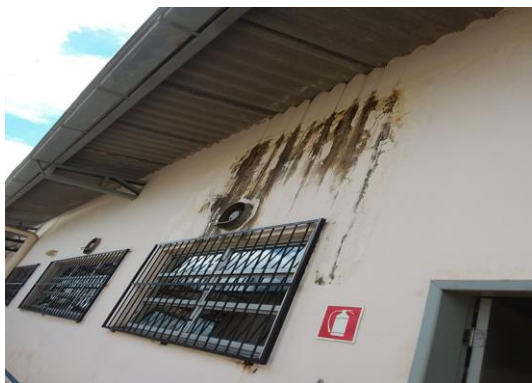
Revestimento danificado/Infiltrações
