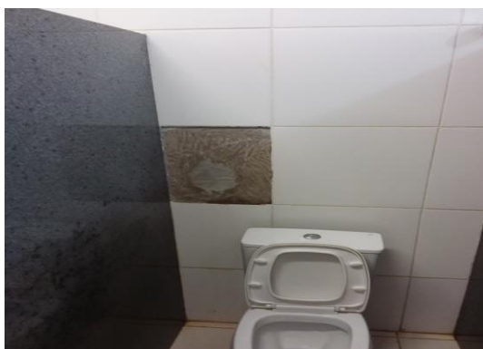
Revestimento danificado
