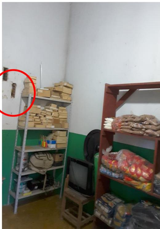
Abertura de ventilação em sala adaptada em depósito (merenda e outros materiais), sem tela de proteção – Escola Santa Júlia
