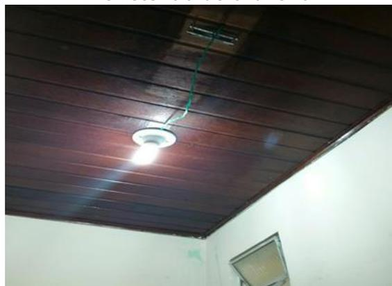
Iluminação insuficiente e Fiação exposta
