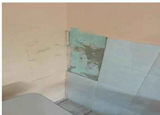
Revestimentos danificados e queda de reboco
