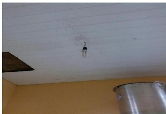
Forro danificado, lâmpada queimada, fiação exposta e inexistência de revestimento
