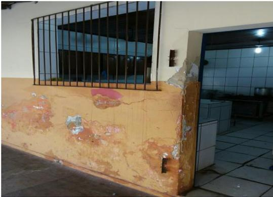
Revestimentos danificados, queda de reboco e infiltração
