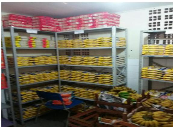
Espaço reduzido, ventilação insuficiente, revestimento incompleto e tela de proteção nas aberturas externas ausente
