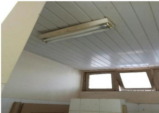
Ventilação insuficiente e lâmpadas queimadas
