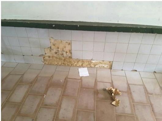
Revestimentos danificados e queda de reboco
