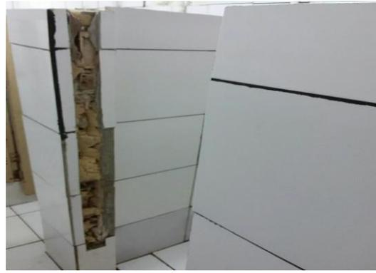
Revestimentos danificados e queda de reboco
