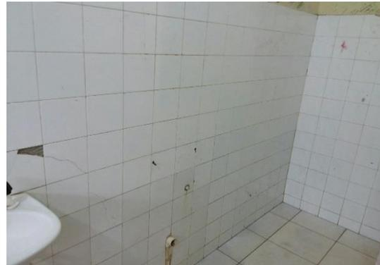
Inexistência de mictório, rachadura e impropriedades no revestimento
