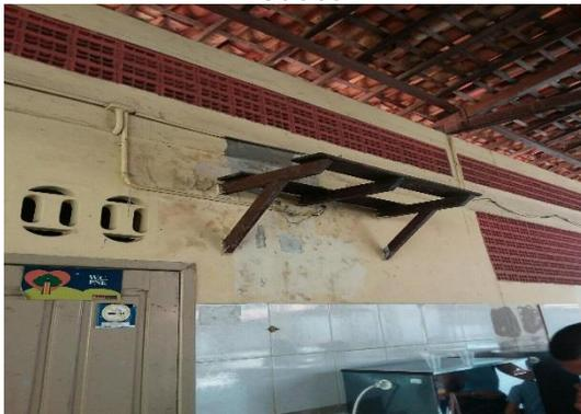
Infiltração e fiação exposta
