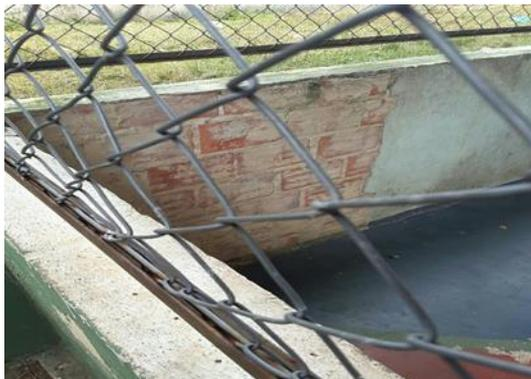
Revestimentos danificados/queda de reboco
