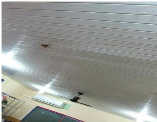
Ar-condicionado e forro danificados e fiação elétrica exposta
