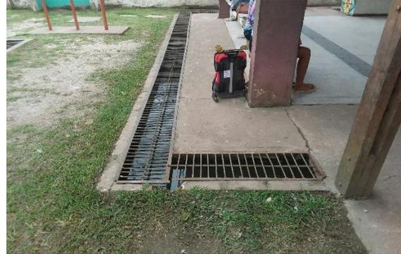
Sistema de drenagem inadequado
