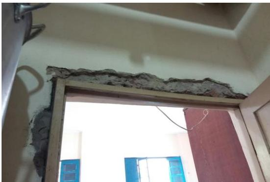
Revestimentos danificados e queda de reboco
