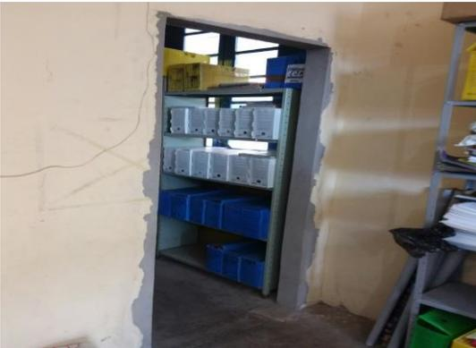
Pintura danificada, fiação exposta e piso desgastado
