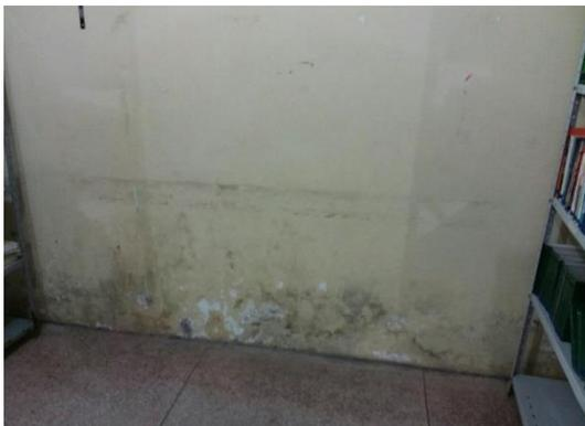
Infiltração e pintura danificada
