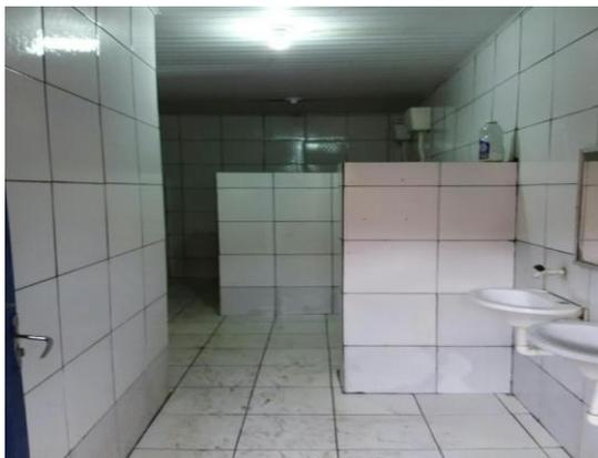
inexistência de ventilação externa
