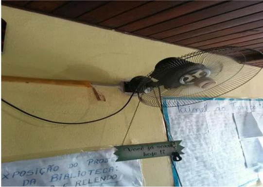
Fiação expostas e improvisadas e ventilador danificado
