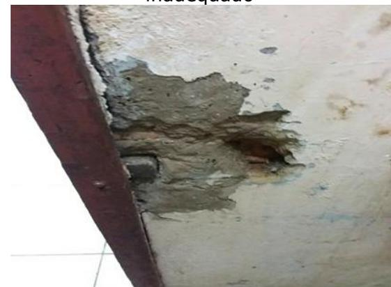
Queda de reboco e pintura danificada
