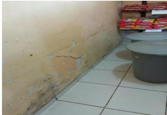
Infiltrações, pintura e inexistência de revestimento nas paredes
