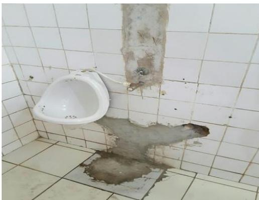
Revestimentos e parede danificados e queda de reboco
