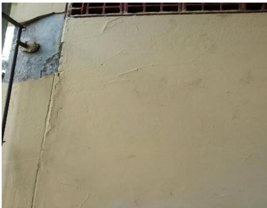
Queda de reboco e pintura danificada
