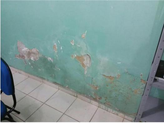
Infiltração de solo e pintura danificada
