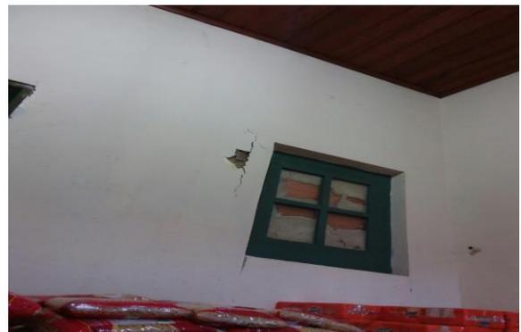
Rachadura, pintura danificada, ventilação natural insuficiente/área de ventilação fechada.
