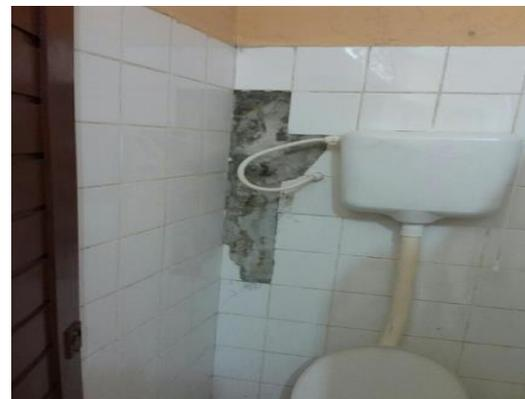
Revestimentos danificados e queda de reboco
