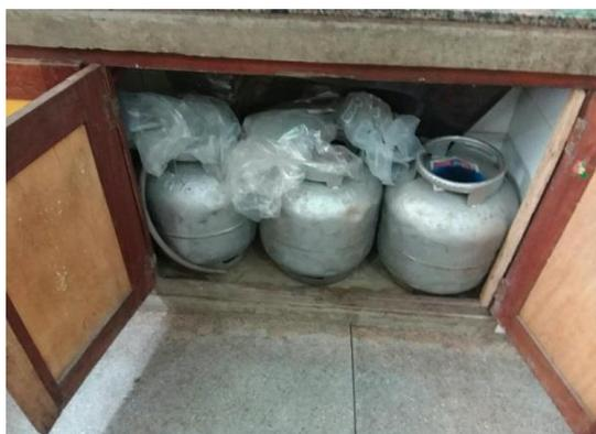
Botijão de gás no ambiente interno e inadequado
