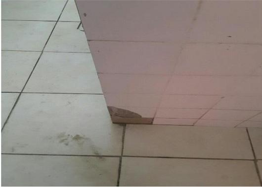
Revestimentos danificados e queda de reboco
