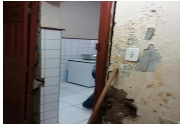
Infiltrações, queda de reboco, porta danificada e inexistência de revestimento
