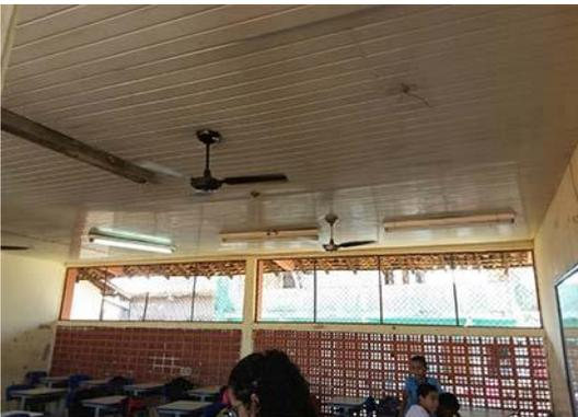
Ventilador e forro danificados, fiação exposta, lâmpadas queimadas e inexistentes
