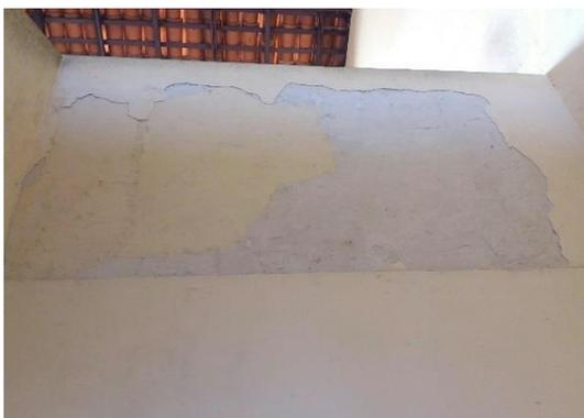
Infiltração e pintura danificada
