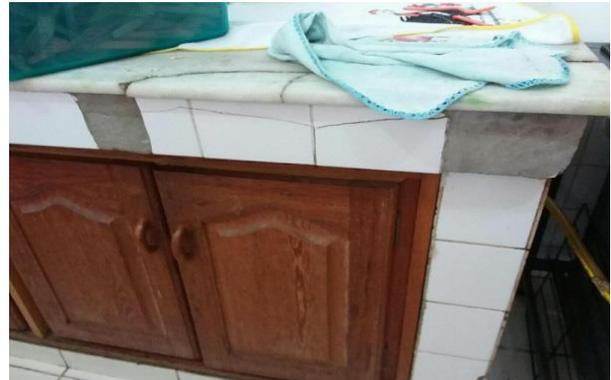
Rachaduras e revestimentos danificados
