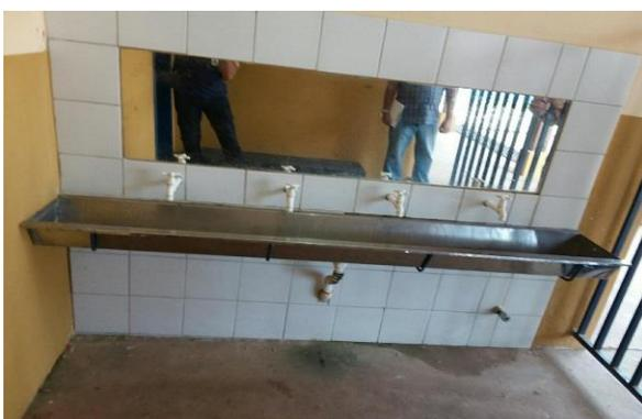
Piso desgastado e vazamentos
