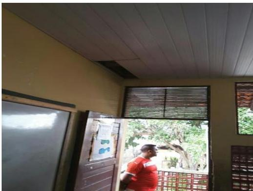
Iluminação insuficiente e forro danificado
