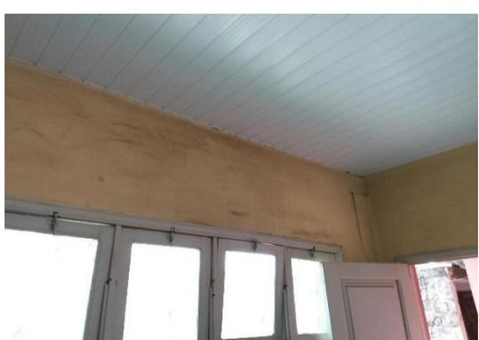
Infiltrações e aberturas externas sem tela de proteção
