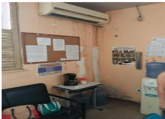
Ar condicionado danificado e infiltrações
