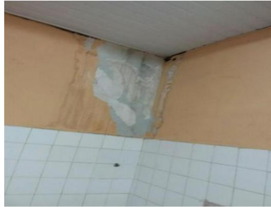
Infiltrações, forro e pintura danificados
