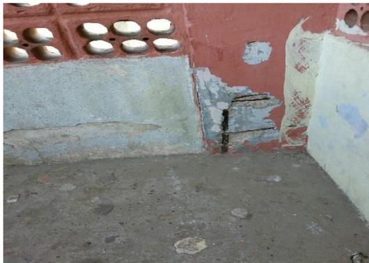
Infiltração, queda de reboco com ferragem exposta e piso danificado
