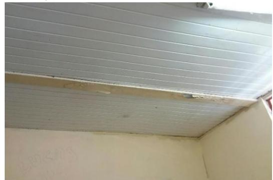
Infiltração e forro danificado
