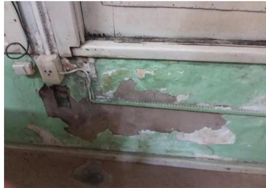
Infiltrações, pintura danificada e fiação exposta
