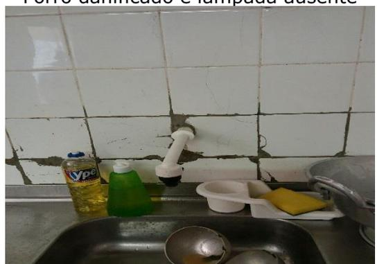
Infiltrações e revestimento danificado
