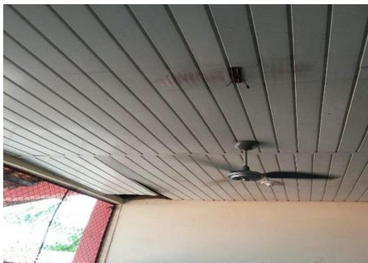
Forro danificado, fiação exposta e inexistência de lâmpada
