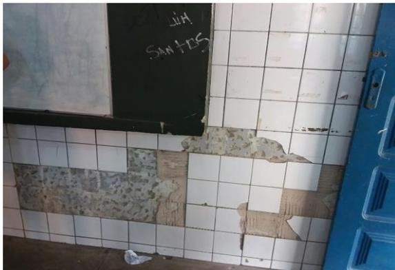
Revestimentos danificados e queda de reboco
