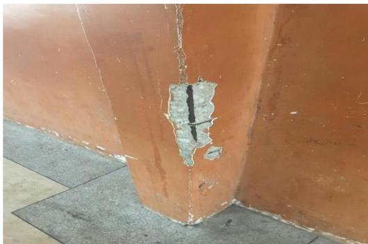
Pintura desgastada e queda de reboco com ferragem exposta
