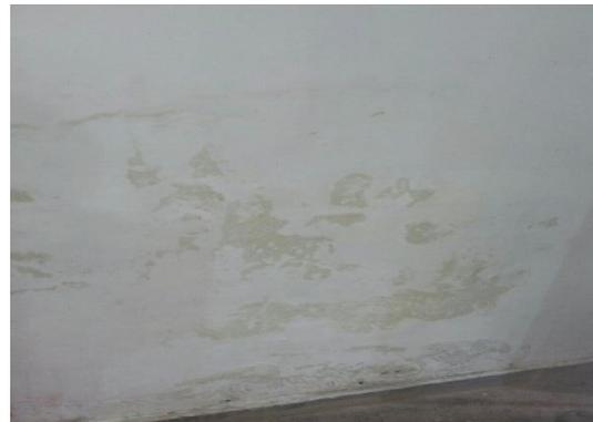
Infiltração e pintura desgastada
