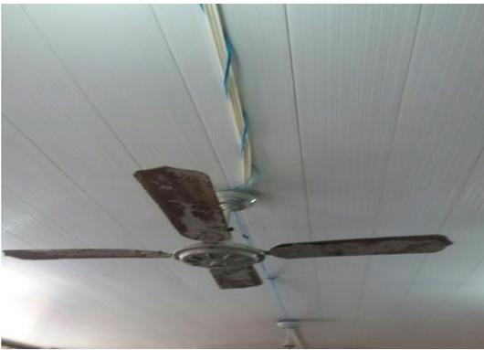
Ventilador danificado e fiação exposta
