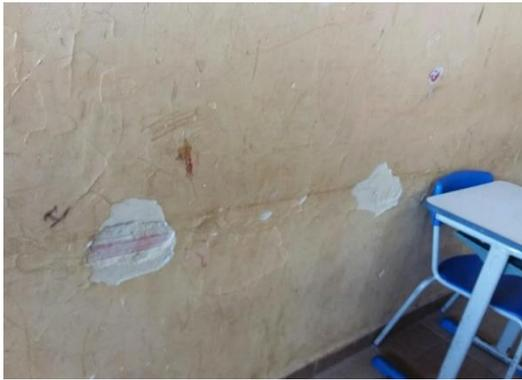
Revestimentos e pintura danificados e queda de reboco
