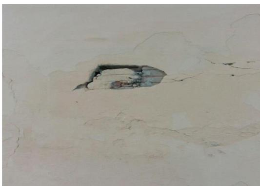
Revestimentos danificados e queda de reboco
