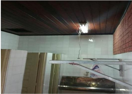
Iluminação insuficiente, forro danificado e fiação exposta
