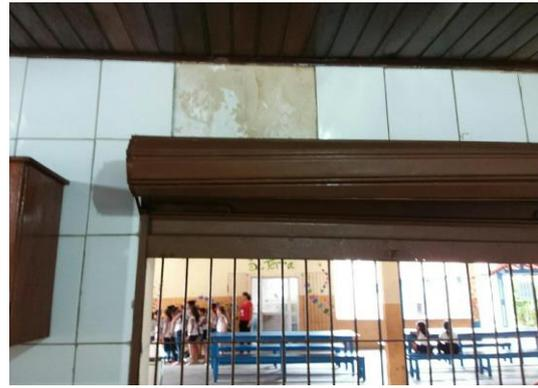
Revestimento danificado, queda de reboco e tela de proteção inexistente
