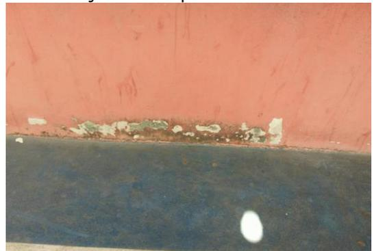
Infiltração e pintura desgastada
