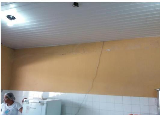
Infiltrações, pintura danificada e fiação exposta e improvisada
