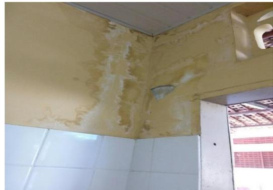
Infiltrações e Queda de reboco
