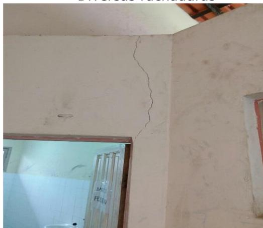
Rachadura e infiltrações
