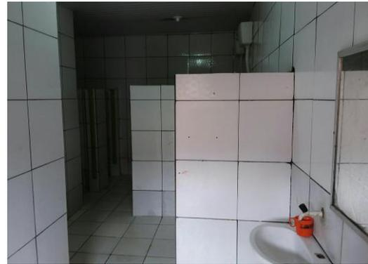
Inexistência de Lâmpada e ventilação externa
