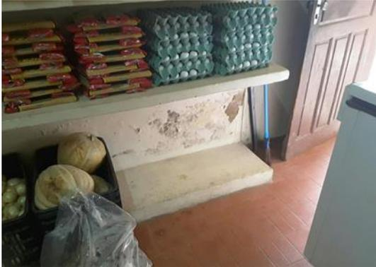
Infiltrações e falta de revestimentos
