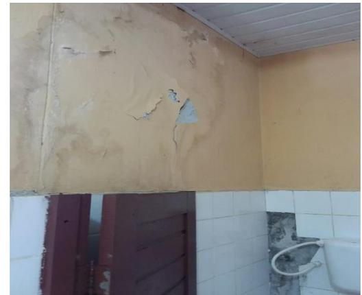
Infiltrações, pintura e revestimento danificados
