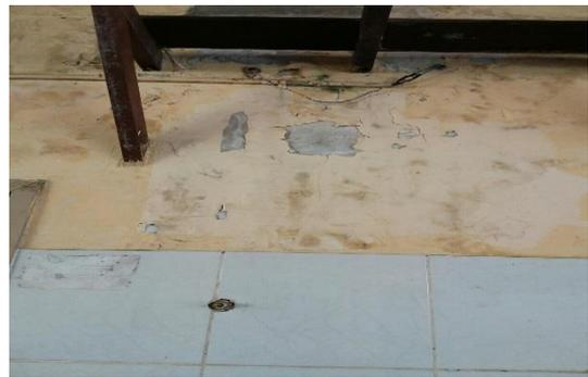
Infiltração, pintura desgastada e fiação exposta
