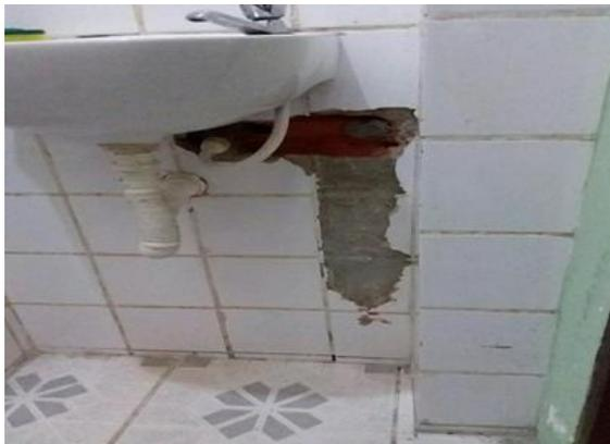
Parede e revestimentos danificados
