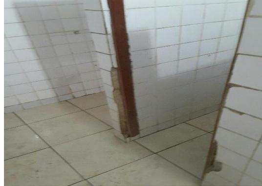
Revestimentos danificados e queda de reboco
