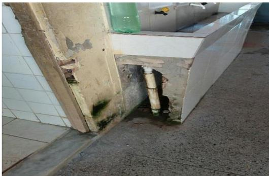
Revestimentos danificados e queda de reboco
