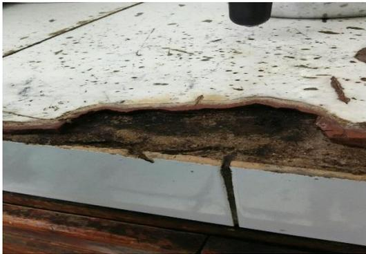
Revestimento e piso danificados e inadequado
