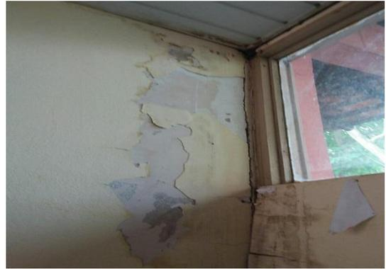
Infiltração e rachadura
