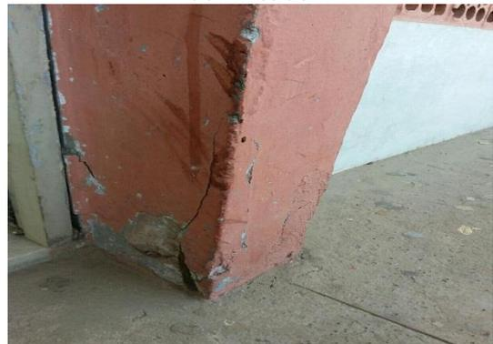
Rachadura e queda de reboco com ferragem exposta
