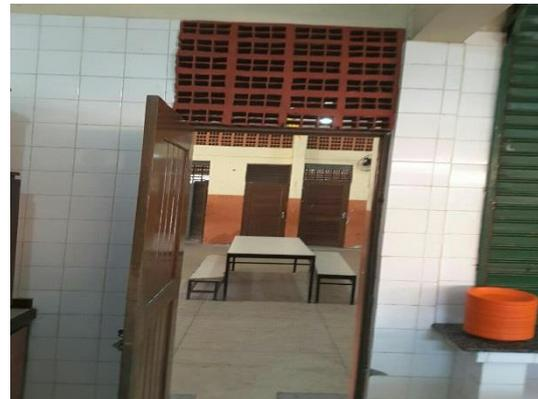
Ventilação insuficiente e inexistência de tela de proteção nas aberturas externas
