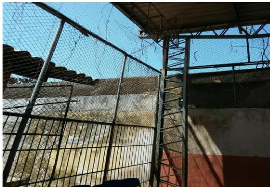
Tela de proteção e telhado danificadas
