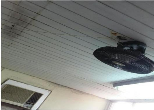
Ar-condicionado e ventilador danificado e fiação exposta
