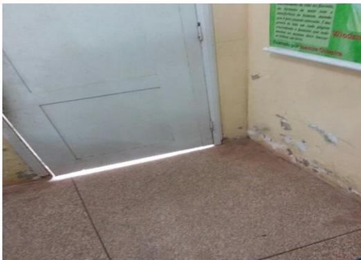
Infiltração e pintura danificada
