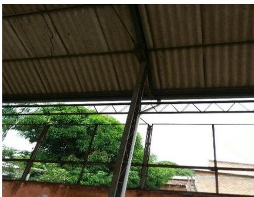
Iluminação insuficiente e tela de proteção danificada
