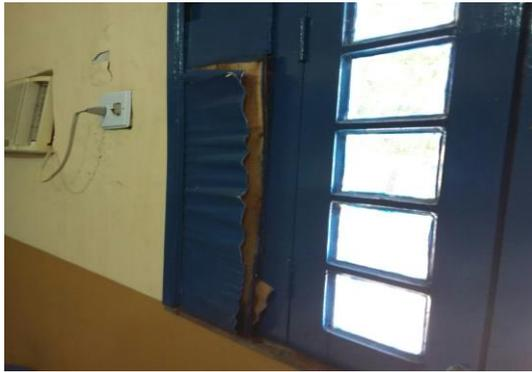
Revestimentos danificados e queda de reboco
