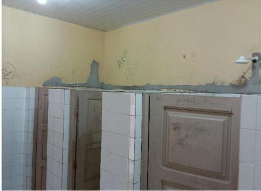
Revestimentos danificados e pintura desgastada
