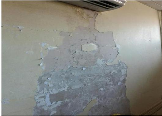
Infiltração, pintura danificada
