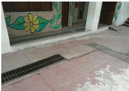
Limitação de acesso para PcD e sistema de drenagem inadequado
