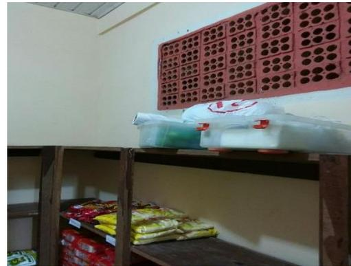
Inexistência de tela de proteção na abertura externa
