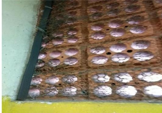
Tela de proteção inadequada e danificada
