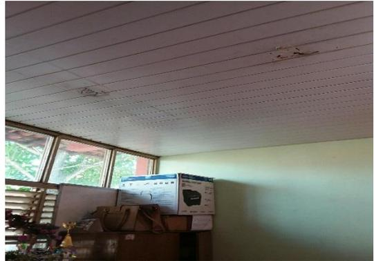
Lâmpadas inexistentes e fiação exposta
