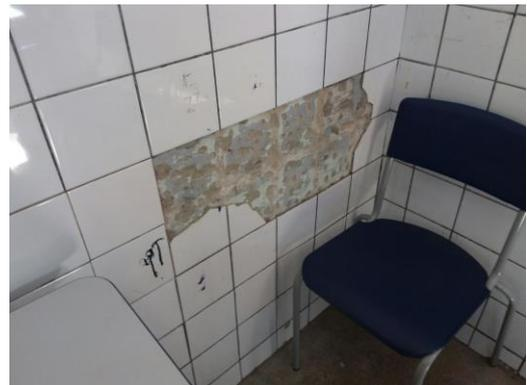
Revestimentos danificados e queda de reboco
