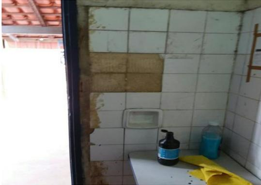
Revestimentos danificados e queda de reboco
