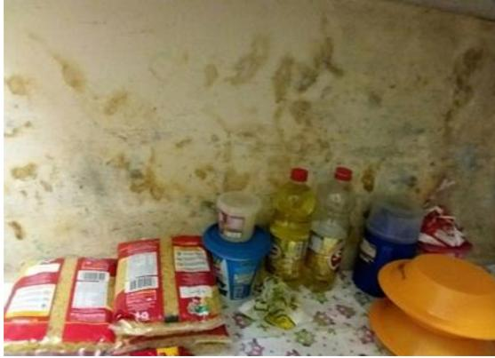
Infiltrações e inexistência de revestimento
