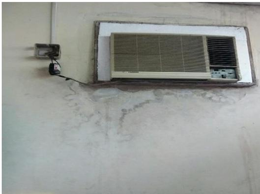
Infiltração e fiação exposta/improvisada
