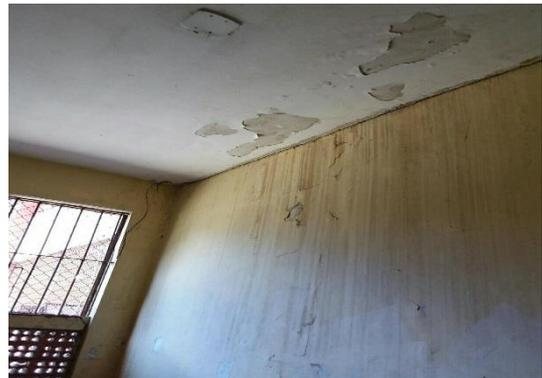
Infiltração, rachadura e pintura danificada
