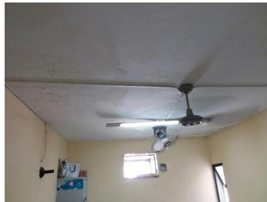
Infiltração, fiação exposta e
