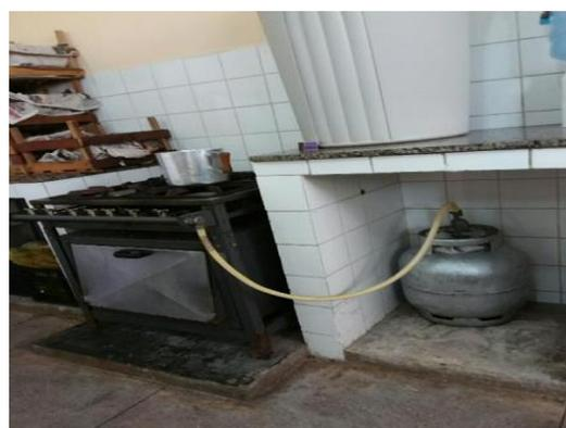
Botijão de gás em ambiente interno e inadequado
