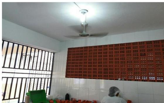
Tela de proteção nas aberturas externas ausente e existência de ventiladores
