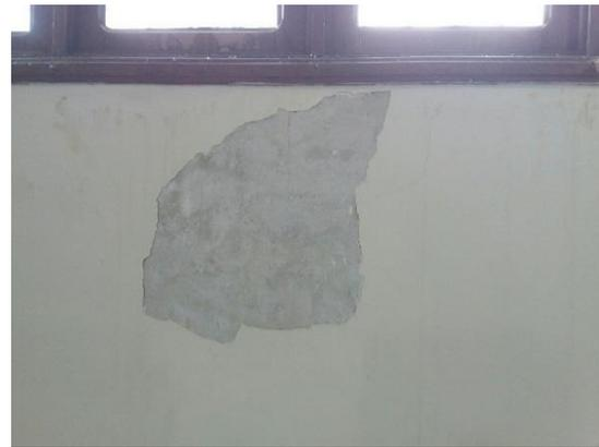
Queda de reboco e pintura danificada
