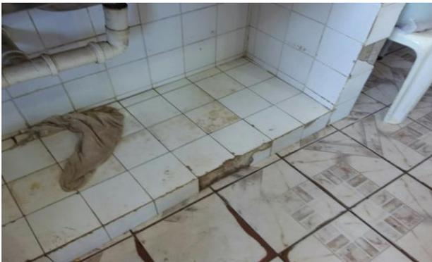
Revestimentos danificados e vazamentos
