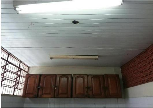
Lâmpadas ausentes e ventilação natural insuficiente
