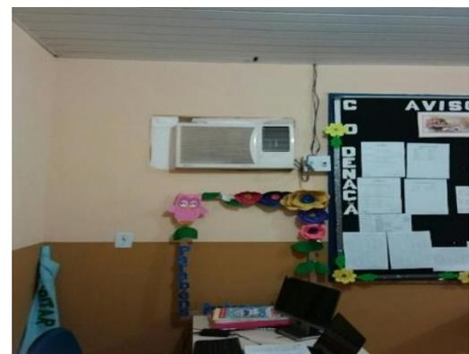
Ar-condicionado danificado e fiação exposta e improvisada
