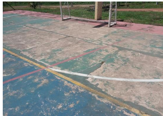
Pintura e marcação de linhas desgastadas
