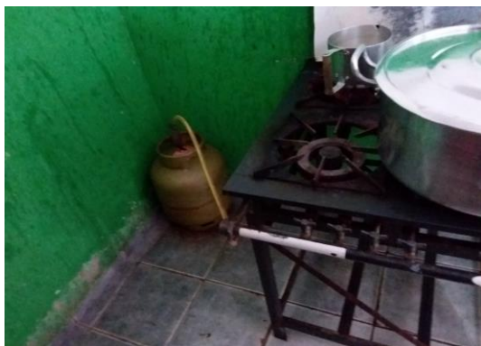
Botijão de gás em ambiente interno
