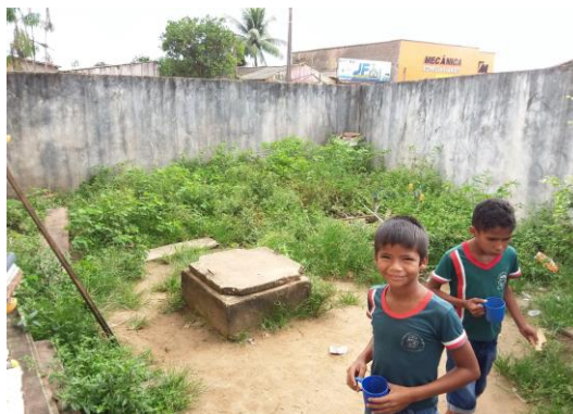
Necessita de capinação
