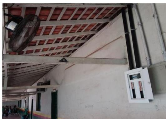
Quadro elétrico sendo ventilado para não superaquecer e desligar os disjuntores.
