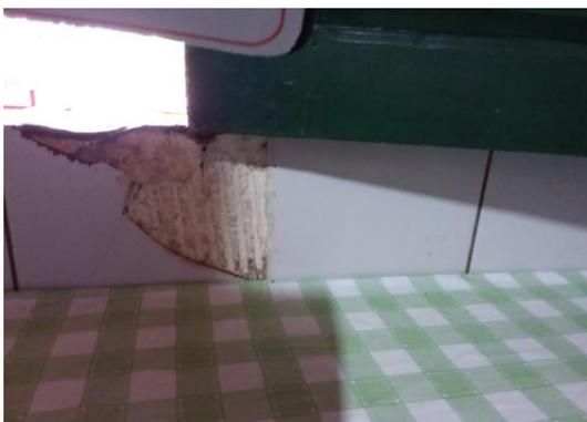
Revestimento danificado/queda de reboco
