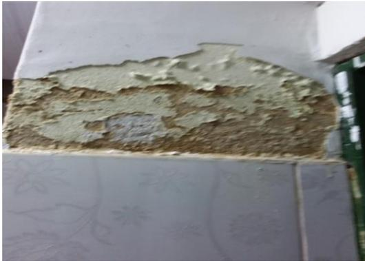
Revestimento danificado/queda de reboco
