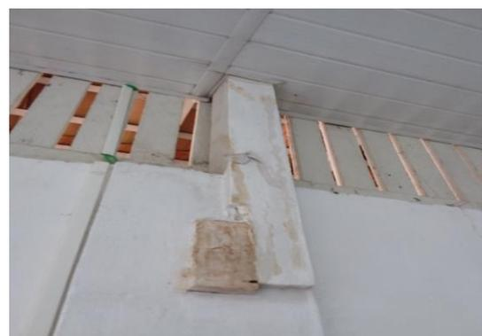
Queda de reboco com ferragem exposta
