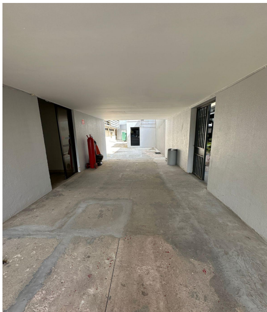
Imagem 3 - Acesso a subestação
