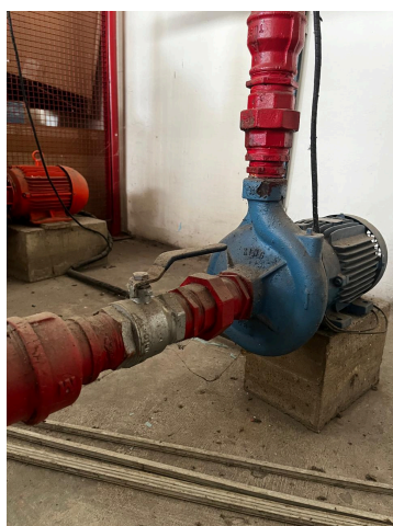
Troca da bomba Jockey de 5CV
