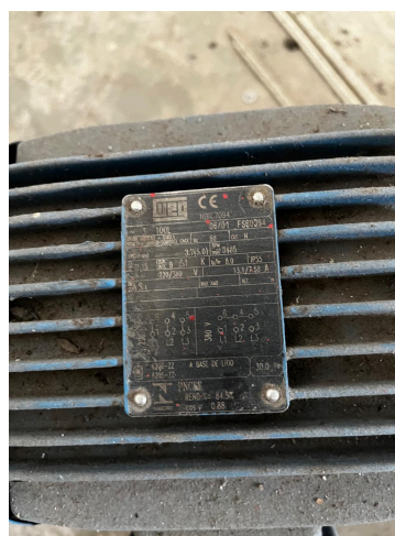
Troca da bomba Jockey de 5CV
