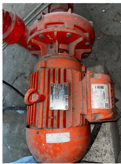
Troca da bomba Centrífuga de 10CV
