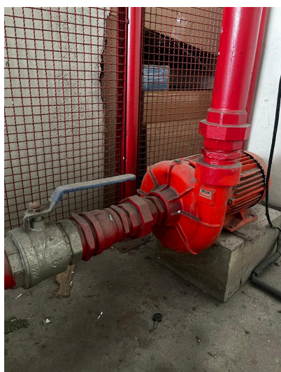
Troca da bomba Centrífuga de 10CV
