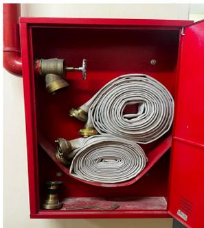
Hidrante 1 - Reparo como um todo e troca das Mangueiras para Tipo II de 15m cada, conforme NBR 11861 - Mangueiras de combate a incêndio.
