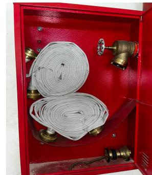
Hidrante 2 - Reparo como um todo e troca das Mangueiras para Tipo II de 15m cada, conforme NBR 11861 - Mangueiras de combate a incêndio.
