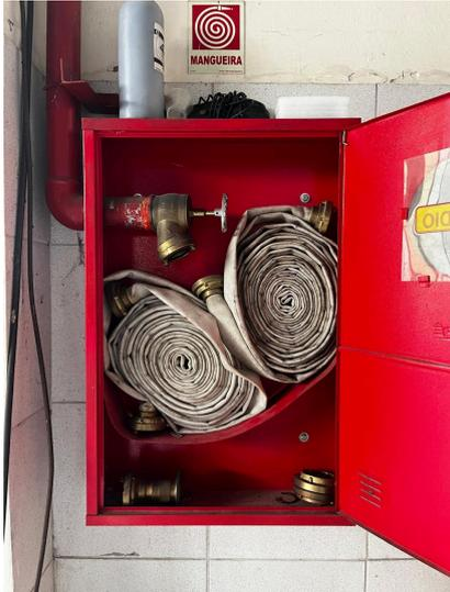
Hidrante 3 - Reparo como um todo e troca das Mangueiras para Tipo II de 15m cada, conforme NBR 11861 - Mangueiras de combate a incêndio.
